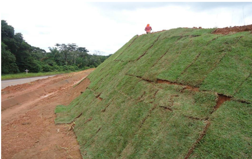
Figura 6 – Aplicação de Grama em Placas (Fonte: SUPRA/DNIT)
