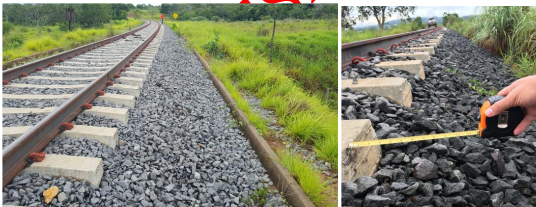
Figura 10 – Insuficiência de Ombreiras (Fonte: Ação de Controle 201700822)
