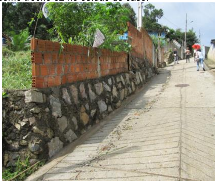
Figura 13 – Comunidade de Monte Serrat, Servidão Nova Descoberta - vista de uma rampa executada em concreto com ranhuras, sem a presença de calçada nas laterais. Área designada como trecho 02 no estudo de caso.
