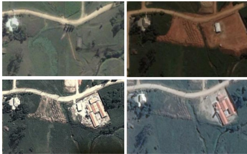
Figura 5.2: Exemplo de creche do programa ProInfância sendo construída ao longo dos anos.
