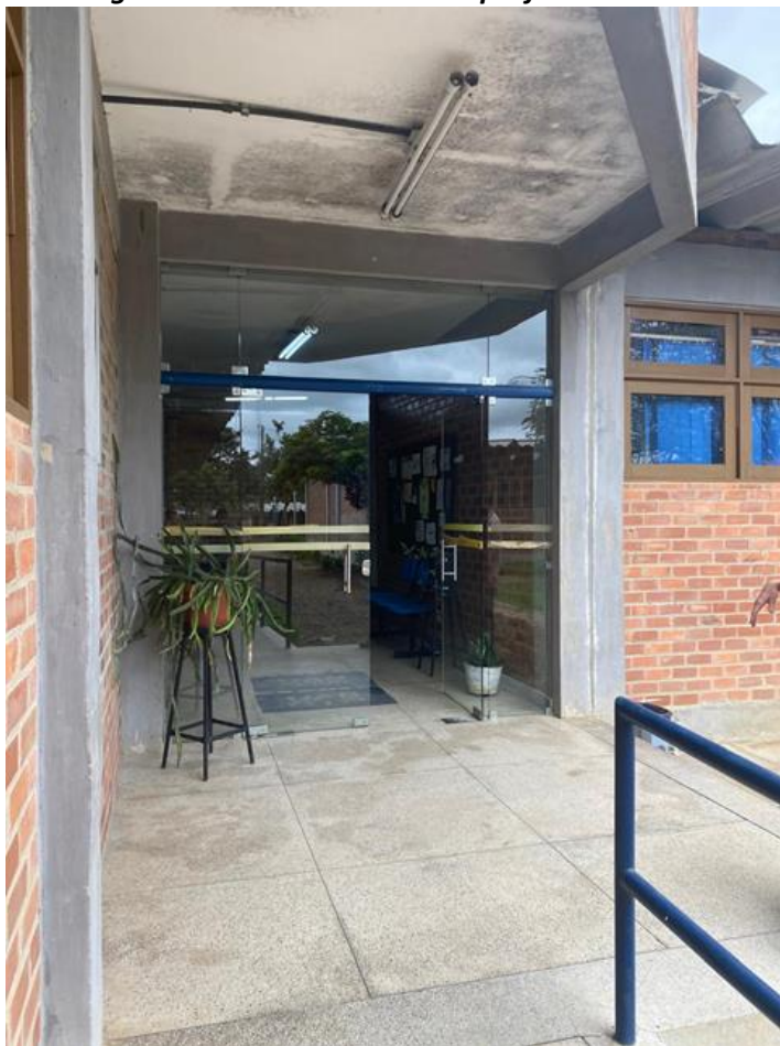
Figura 01: Prédio da sala dos professores
