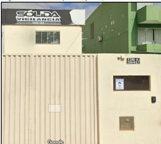
Figura 2 – fachada do endereço SAAN, Quadra 1, Lote 1280
