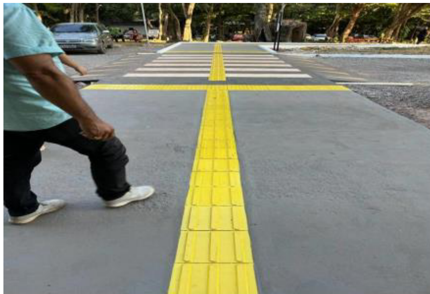
Figura 01 – Rampa de acessibilidade da ufopa
