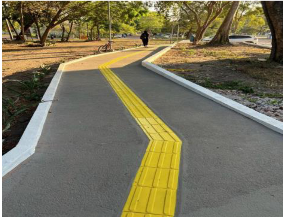
Figura 02 – Rampa de acessibilidade da ufopa
