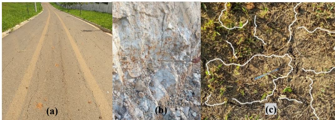
Figura 2. (a) Trincas Longas Longitudinais no Pavimento após a construção; (b) Perfil típico do solo coletado; (c) Ocorrência generalizada de trincas de retração na superfície durante o período seco.
