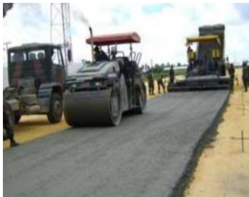
Figura 30. Aplicação de CCR Fonte: Klinsky (2019)
