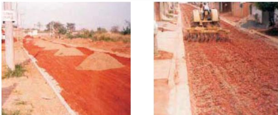
Figura 33. Aplicação de solo areia Fonte: Klinsky (2019)
