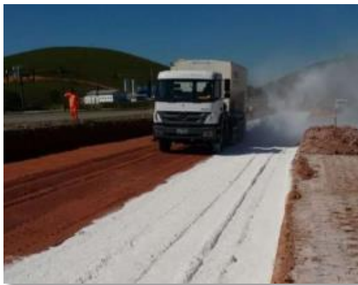
Figura 28. Aplicação de solo-cal Fonte: Klinsky (2019)
