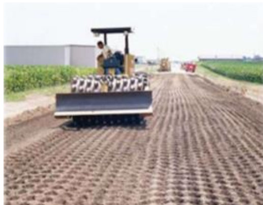
Figura 27. Aplicação de solo cimento
